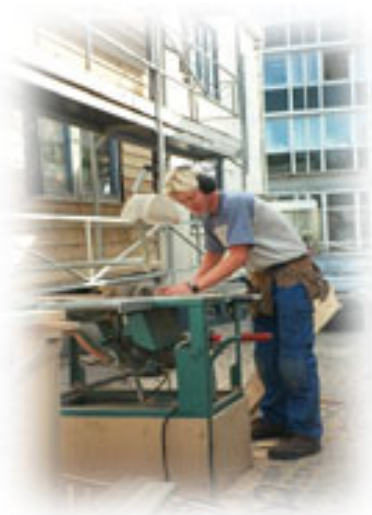
Tømrer i arbeid
